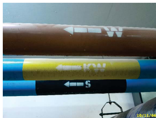
ระบบระบายน้ำภายในอาคาร (S W K)
