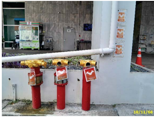
หัวต่อสายฉีดน้ำดับเพลิงชนิดหัวต่อสวมเร็ว
